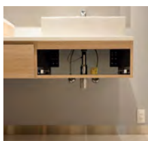
イメージ：壁給水／壁排水
