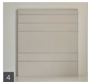
4 最上段パネルの設置
