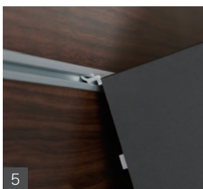
5 BOXの掛け金具をレールに引っ掛けて取り付けます。
